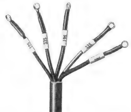
Bild 6. Kennzeichnen von Kabeladern und Kabelschuhen durch Tesadur-Bezeichnungsband
